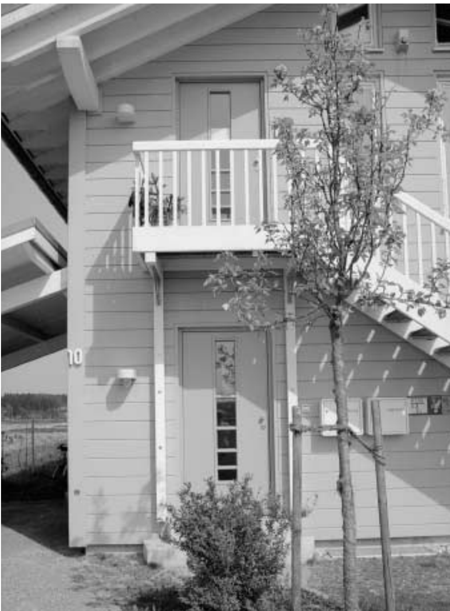
Bild 27 Außentreppe am Sonnenhaus
