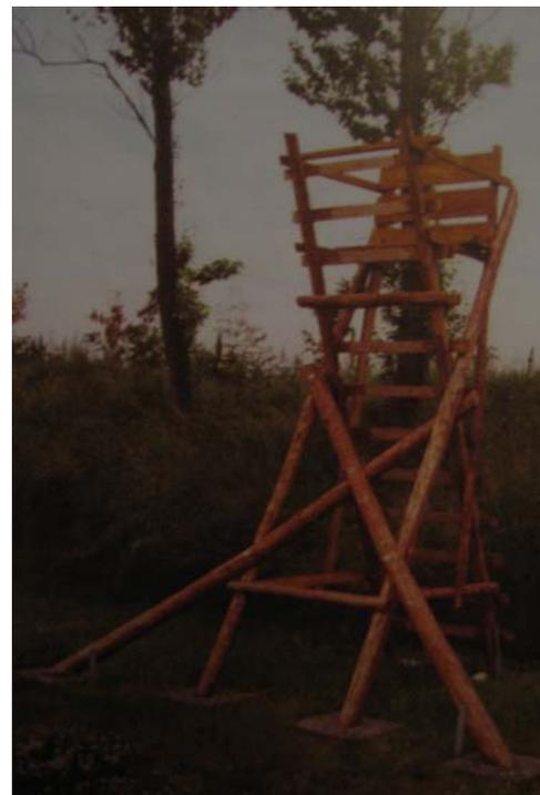
Bild 4: Absicherung durch Querstreben
