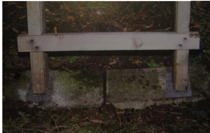
Zusätzlich zu einem richtig dimensionierten Fundament sollte die Hochsitzeinrichtung mittels Querstreben abgesichert werden (Bild 3 und 4, Quelle [1]):
