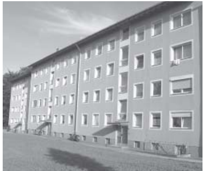
Abb. 10.2: Wohngebäude 4-geschossig, BJ 1954. U_{\text{Kellerdecke}} 0.80 W/(m 2 K) U_{\text{Decke OG}} 1.2 W/(m 2 K) U_{\text{Außenwand, alt}} 1.71 W/(m 2 K) U_{\text{Außenwand, neu}} 0.32 W/(m 2 K) U_{\text{Fenster, alt}} 2.9 W/(m 2 K) U_{\text{Fenster, neu}} 1.20 W/(m 2 K) Jahresheizwärmebedarf alt ca. 179 kWh/(m 2 a), neu ca. 83 kWh/(m 2 a)
