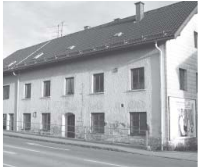
Abb. 10.1: Wohngebäude 2-geschossig, BJ ca. 1938. U_{\text{Kellerdecke}} 0.97 W/(m 2 K) U_{\text{Decke OG}} 1.2 W/(m 2 K) U_{\text{Außenwand, alt}} 1.80 W/(m 2 K) U_{\text{Außenwand, neu}} 0.33 W/(m 2 K) U_{\text{Fenster, alt}} 6.0 W/(m 2 K) U_{\text{Fenster, neu}} 1.20 W/(m 2 K) Jahresheizwärmebedarf alt ca. 289 kWh/(m 2 a), neu ca. 110 kWh/(m 2 a)
