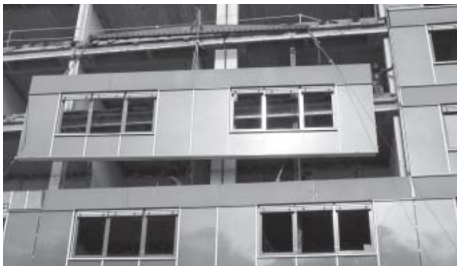
Abb. 8.3: Positionierung eines geschosshohen Holztafelementes an der offenen Fassade
