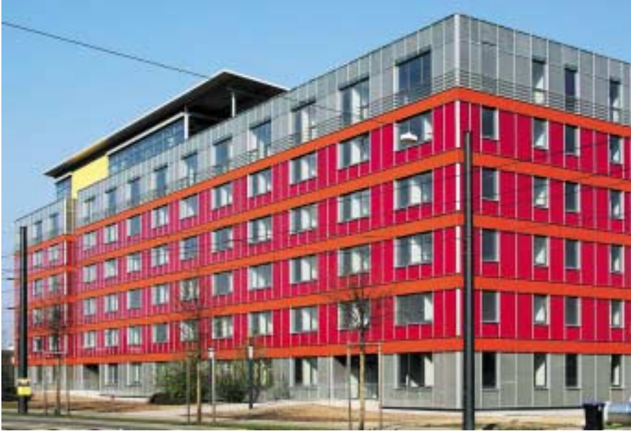
Abb. 8.4: Gebäudekomplex nach Abschluss der Fassadenarbeiten
