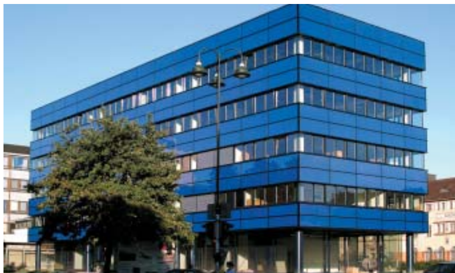
Abb. 3.10: Fassade nach Abschluss der Sanierungsarbeiten
