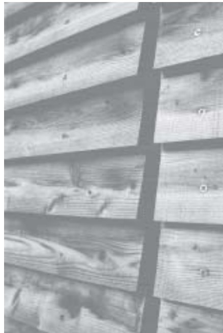
Abb. 4.1: Stülp-schalung in Lärche ohne Anstrichstoffe
