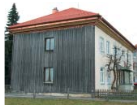
Abb. 2.5: Vorgehängte unterlüftete Boden-Deckel-Schalung in Holzart Lärche
