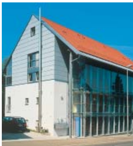
Abb. 3.8: Sanierung Fassade Wohngebäude mit Holzwerkstoffplatten und Glasvorbau
