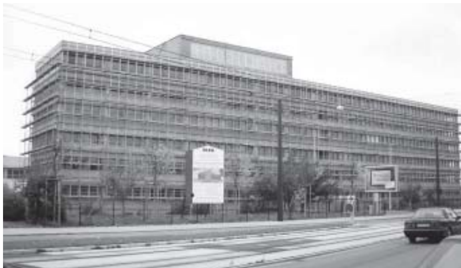
Abb. 8.1: Mehrgeschossiger Plattenbau vor Beginn der Sanierungsmaßnahmen
