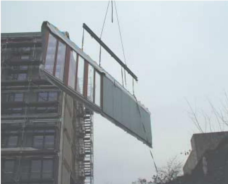
Abb. 8.7: Gerüstlose Montage Fassadenelemente in Holztafelbauweise
