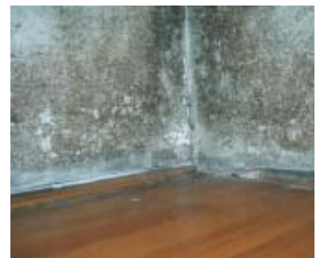
Abb. 3.7: Gebäude wie vor, Innenaufnahme Außenwand OG, starker Schimmelpilzbefall
