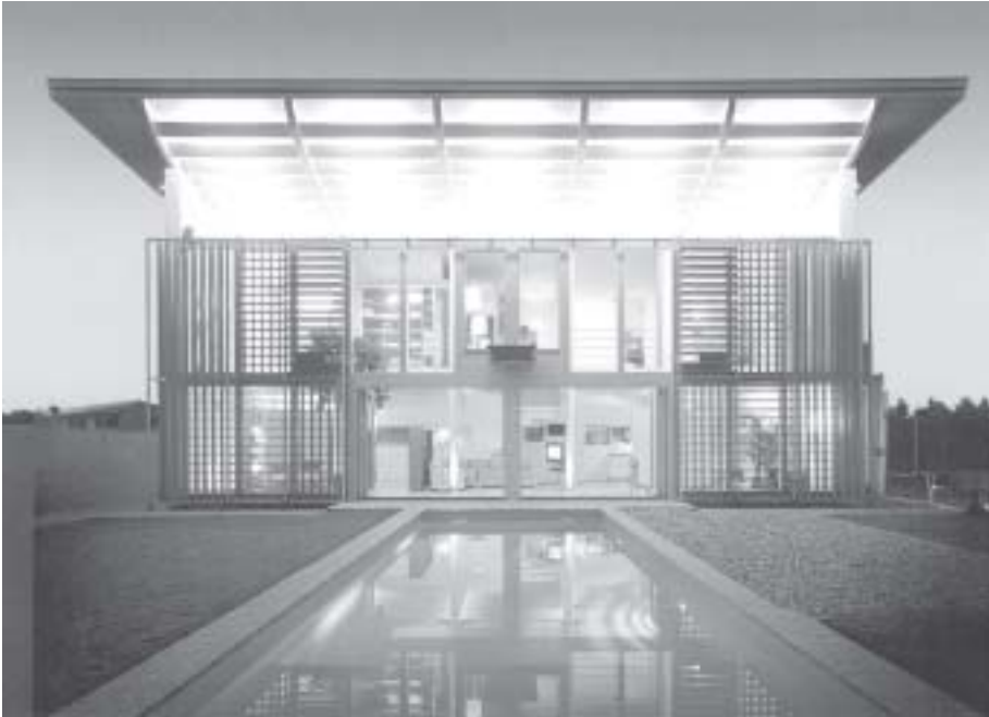
Abb. 6.5: Fassadenelemente mit Lamellen, verfahr- und verstellbar
