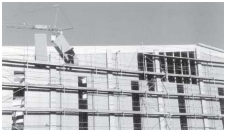
Abb. 6.6: Geschosshohe Fassadenplatten mit 3-Schicht-Platten
