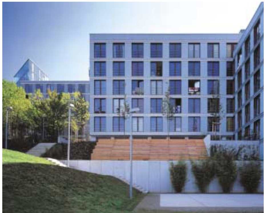
Abb. 8.6: Anlage nach Abschluss der Umbaumaßnahmen
