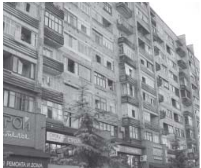
Abb. 10.3: Wohngebäude 10-geschossig, BJ ca. 1950. U_{\text{Kellerdecke}} 0.80 W/(m 2 K) U_{\text{Decke OG}} 1.5 W/(m 2 K) U_{\text{Außenwand, alt}} 2.20 W/(m 2 K) U_{\text{Außenwand, neu}} 0.35 W/(m 2 K) U_{\text{Fenster, alt}} 6.0 W/(m 2 K) U_{\text{Fenster, neu}} 1.20 W/(m 2 K) Jahresheizwärmebedarf alt ca. 143 kWh/(m 2 a), neu ca. 48 kWh/(m 2 a)
