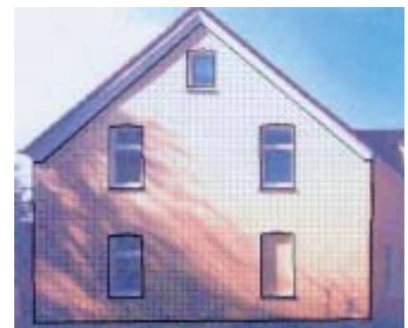
Abb. 7.3: Entzerrte Bildaufnahme Giebelwand
