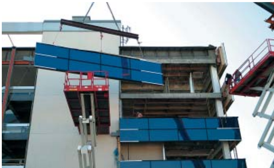
Abb. 3.9: Sanierung Gebäudefassade eines Versicherungsunternehmens während der Montagearbeiten
