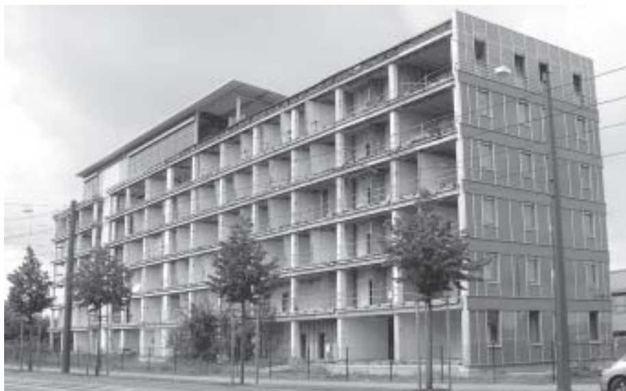
Abb. 8.2: Mit Holztafelementen erneuerte Stirnseite des Plattenbaues. Noch offene Fassade an der Längsseite
