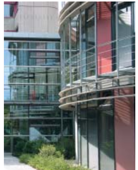
Abb. 6.10: An- und Neubau einer Holz-Glas-Fassade in Kombination mit beschichteten Holzwerkstoffplatten
